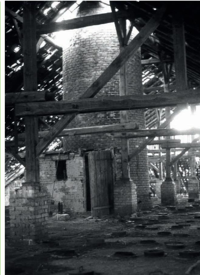
*Auf dem Ringofen, überall sind die Brennluken, durch die der Torf zum Brand gegeben wurde, ca. 1950. Foto: Teebken*
